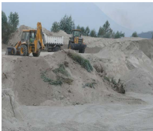
Foto N° 1. Toma de las reservas de Puzolana que se explotan junto a la rivera del río Blanco de San José de Quichinche, materia prima para la elaboración del cemento.
