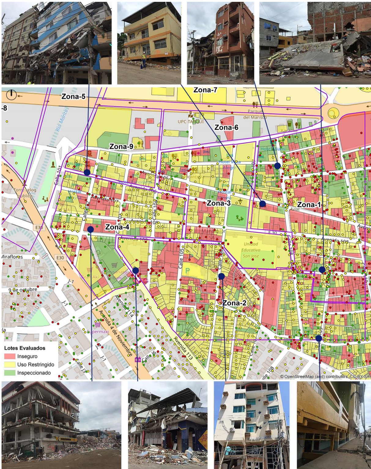
Ilustración 10: Daños a estructuras. Elaboración: Informe de zonificación geotécnica del “Estudio Geotécnico y de Riesgo Sísmico de la zona Tarqui de la Ciudad de Manta de acuerdo a la Norma Ecuatoriana de la Construcción”, 2016.
