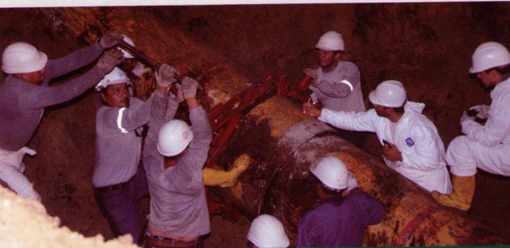
Tareas de reparación en la zona de la rotura de la tubería.
