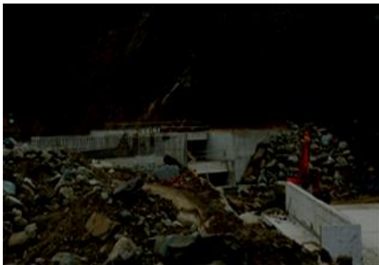
Imagen 2. Construcción del Proyecto Hidroeléctrico Hidrotambo S.A.
