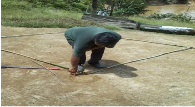
Figura 1. Medición del terreno de la casa.
