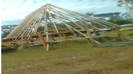
Figura 3. Terminado la armazón de la casa
