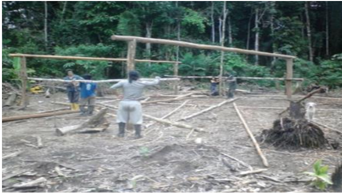
Figura 2. Clavando los cuatro postes más principales
