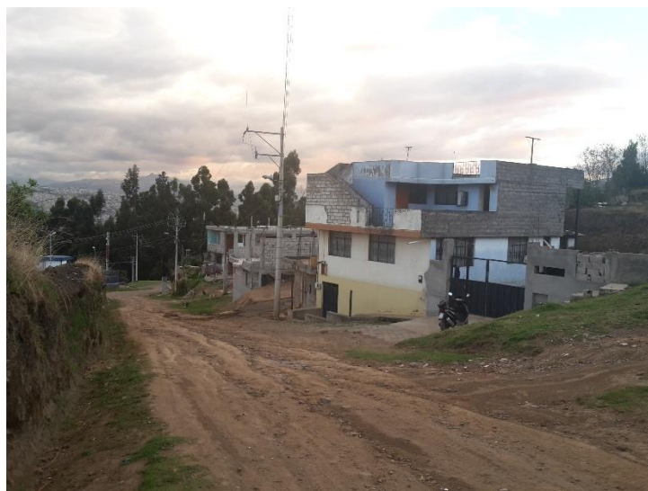
Fotografía N°18. Conjunto de casas construidas en las partes bajas del territorio, las cuales cuentan con servicios básicos. Autor: Darío León.
