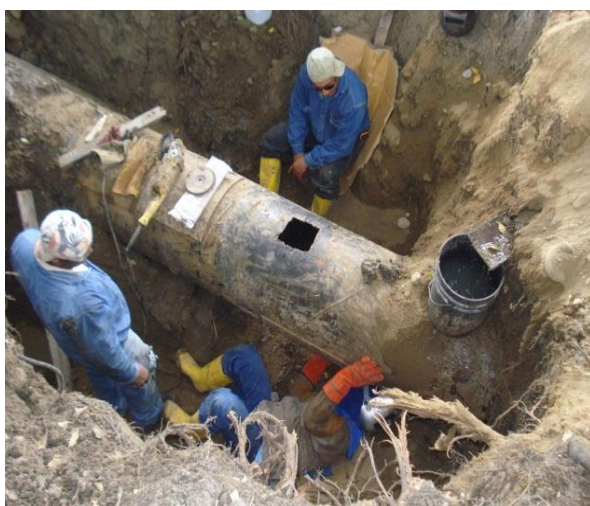
Foto 1. Reparación de un tramo de tubería principal en la ciudad de Esmeraldas.
