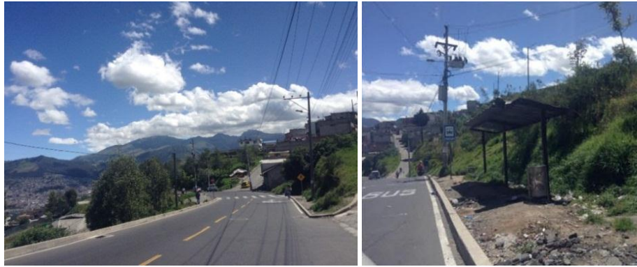
Fotografía 22.- Estado Actual de la calle 21 de agosto
