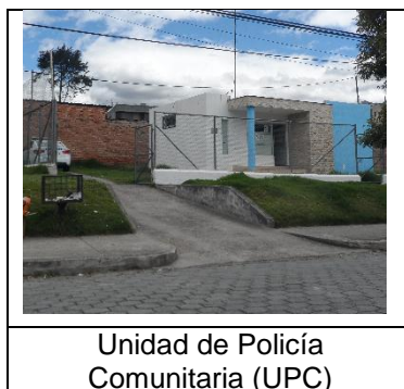
Fotografía 4.- Equipamientos de Seguridad del Barrio Monteserrín
