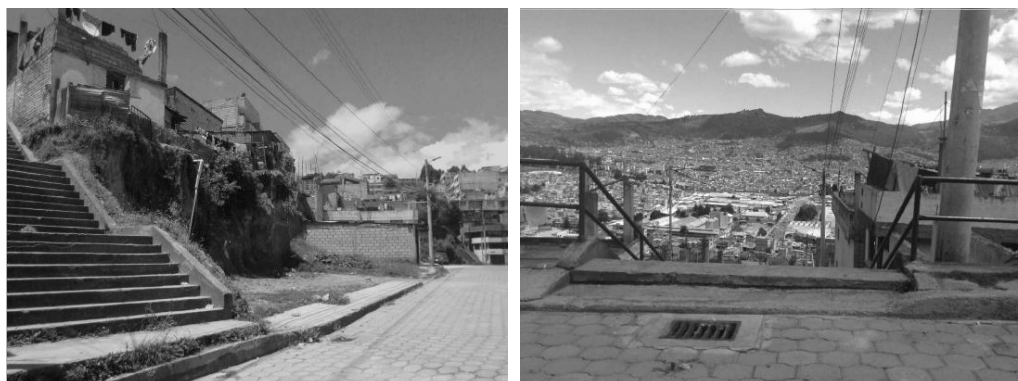
Fotografía 23.- Estado Actual escaleras Lucha de los Pobres Baja
