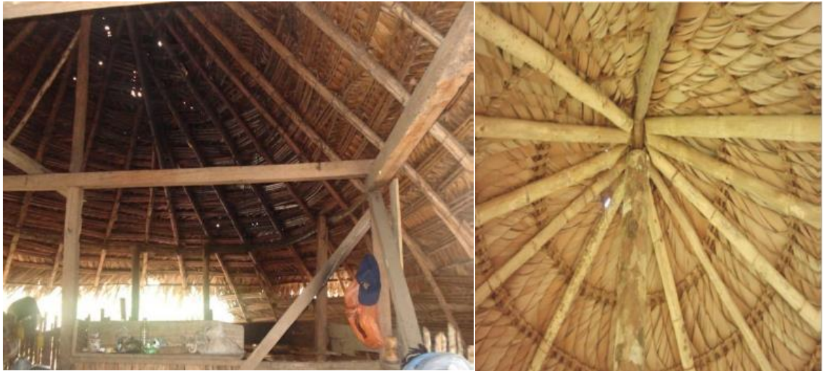
Fotos N° 20 y 21 Vistas de techos de la casa shuar. Tomadas de: La vivienda shuar al suroriente ecuatoriano. Iliana Elizabeth Herrera Herrera. s/f. pd
