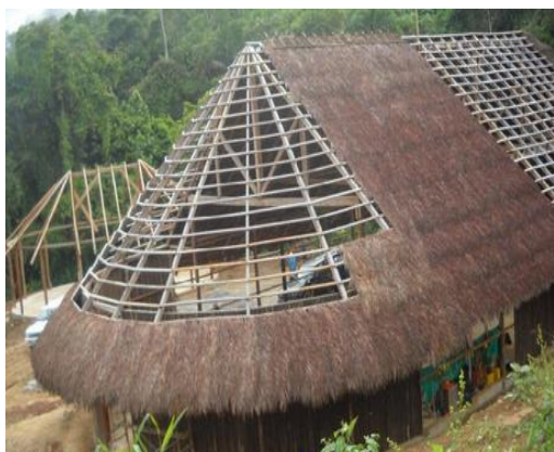
Foto N° 14. Casa shuar en construcción.
